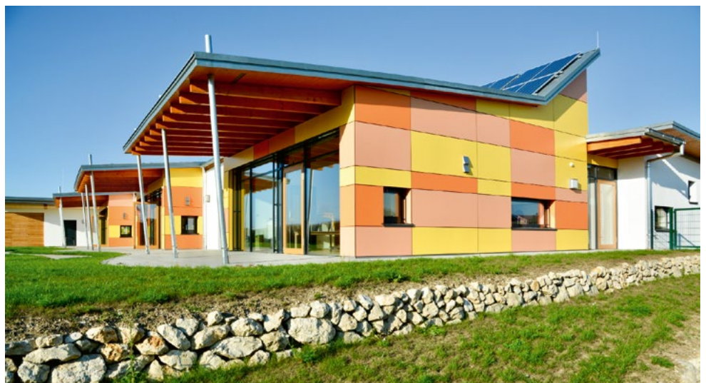
Foto: © Unipor / Architekturbüro Finsterer
